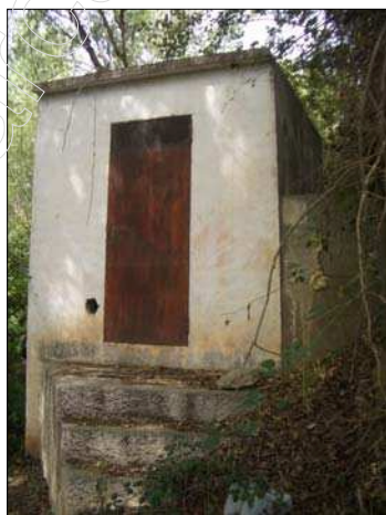
Fig. 5 Depósito, próximo a la fuente Tajadero
