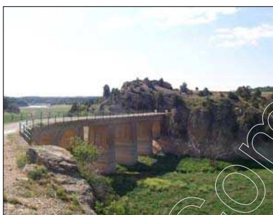
Fig. 17 Puente de Aguan
