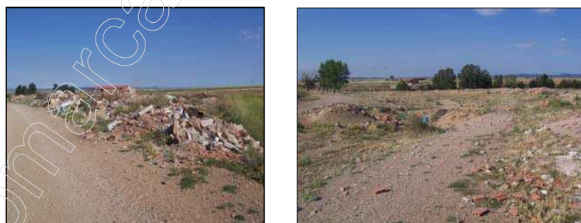
Fig. 23 Vistas de la escombrera
